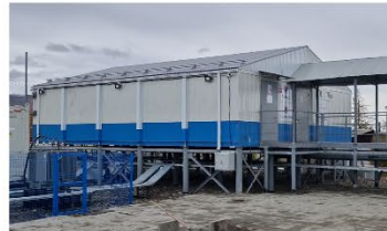
Здание РУ 6,3 кВ, 50 Гц
