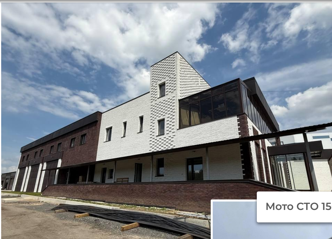
Офис+производство 1500м 2 , Химки
